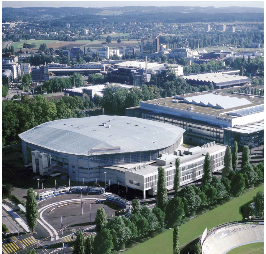
Das sanierte und erweiterte Hallenstadion Zürich-Oerlikon mit Conference-Annex.
